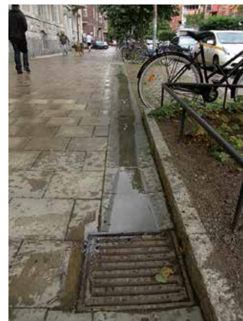
Dagvattenränna med luftningsbrunn kopplad till växtbädd.
