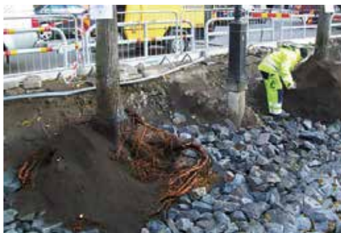
Växtbäddsrenovering på Birger Jarlsgatan.
