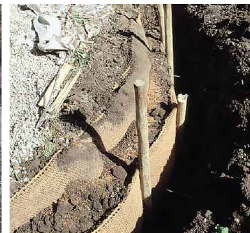
Fig. 3. Rottraperi av kokosmatta monterad mot träpålar samt fuktig jord. När återfyllnadsarbeten ej kan utföras omgäende skyddar rottraperiet trädrötterna från uttorkning.
