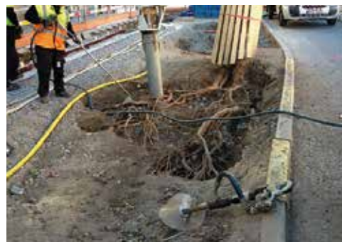
Vakuumschakt / friläggande av rotsystem på vuxna träd med tryckluftslans.
