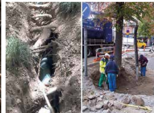
Tunnling av ledning under rötter med hjälp av vakuumschakt.
