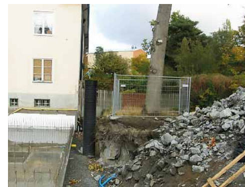
Alla träd är inte möjliga att spara vid nybyggnation. Detta träd har ingen chans att överleva.
